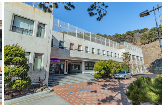
▲ 승학캠퍼스 학군단 건물
